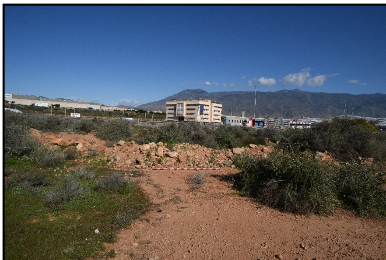
Movimientos de tierra.
