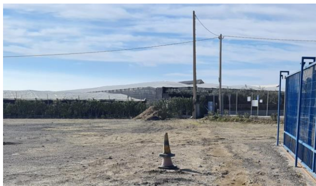
Poste de entronque fuera de la parcela
