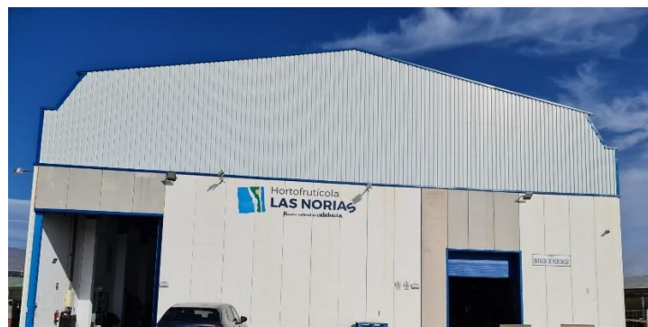
Iluminación exterior en fachada
