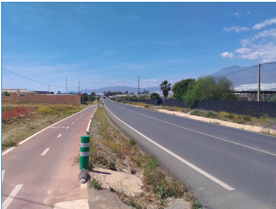
Visibilidad desde el acceso sentido Las Norias
