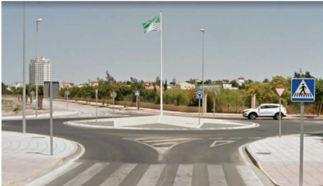
Foto 7. Glorieta ejecutada en la intersección entre la calle Arquitecto Pérez de Arenaza y camino Cañada de Ugíjar
