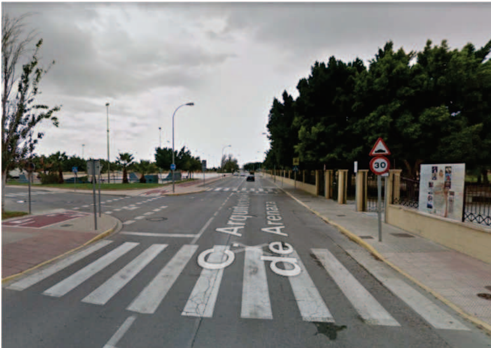
Foto 5. Estado actual de la calle Arquitecto Pérez de Arenaza
