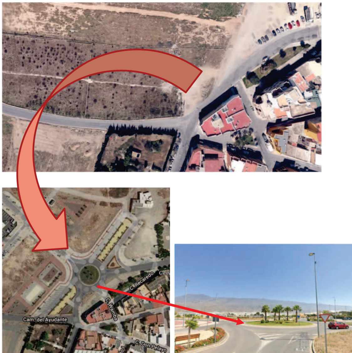
Glorieta ejecutada en la intersección de la Avda. Príncipes de España con c/ Fernán González
