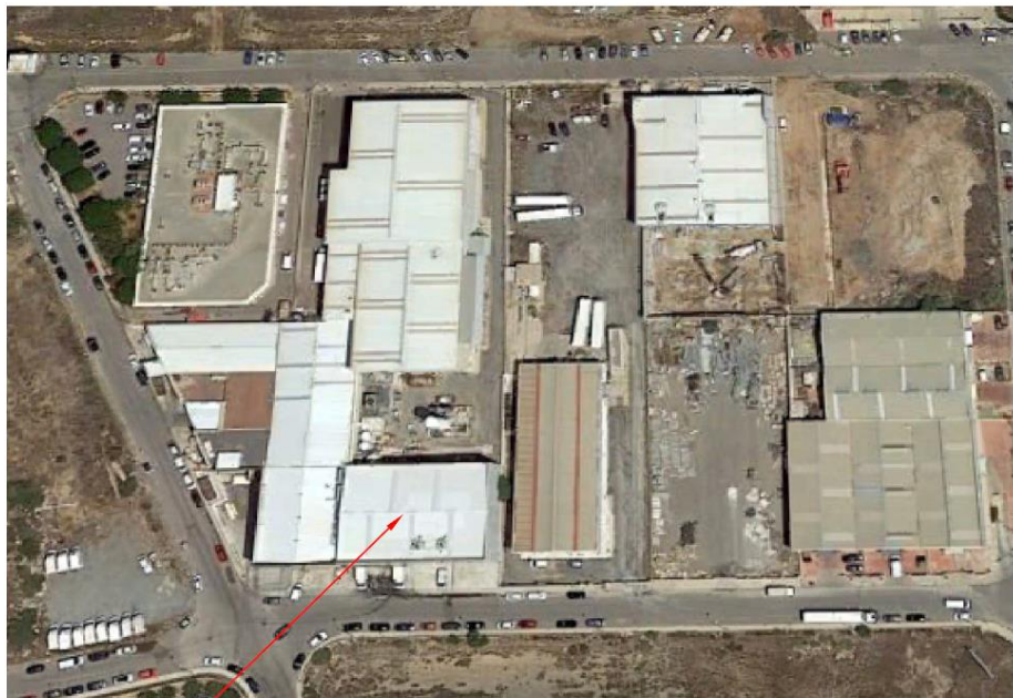
UBICACIÓN DE LA NAVE
