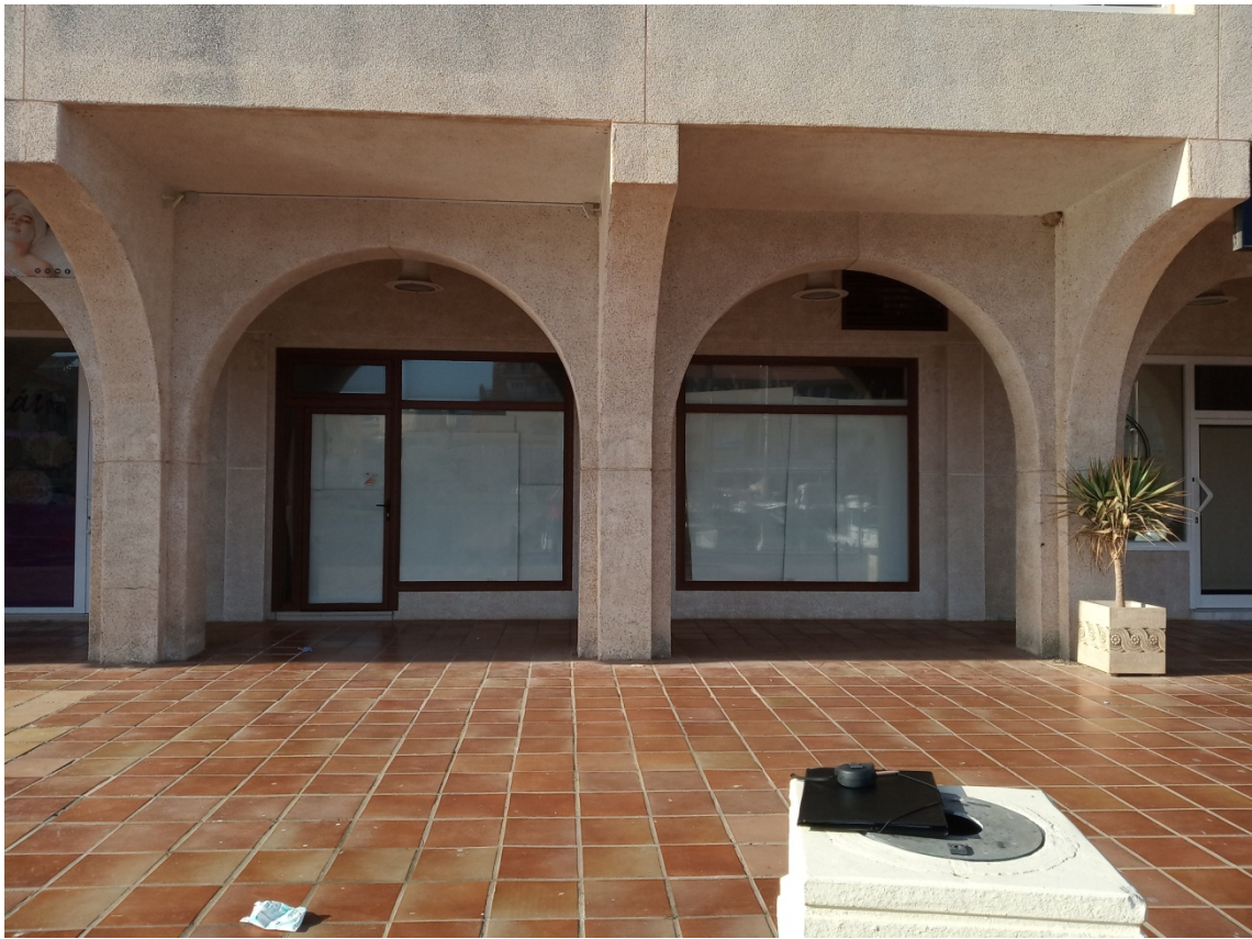
Fig. 1.- Fachada a Dársena.
